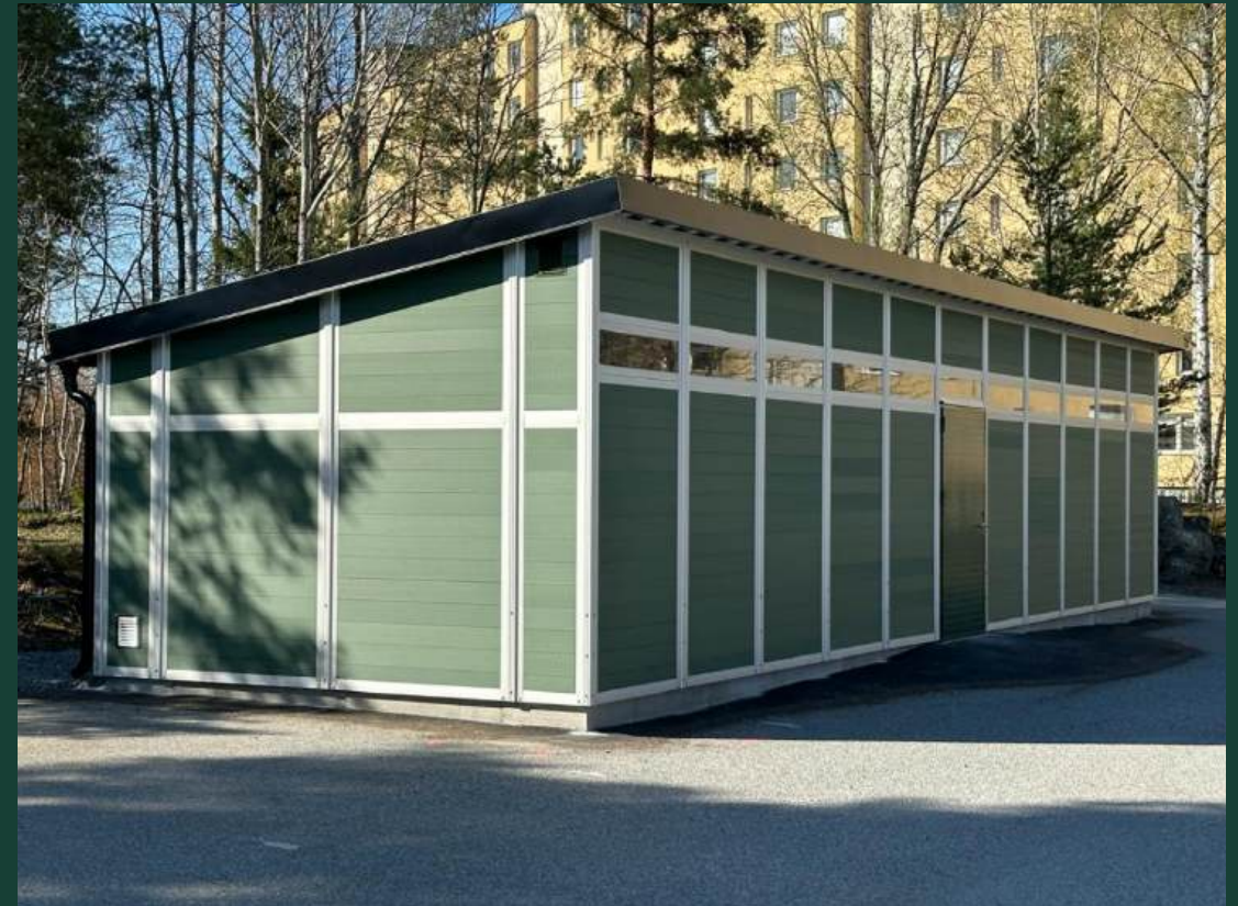
Exempel på grön fasad med ljusa ramverk.
